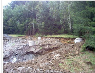
Foto 3: Quelfassung mit Entnahmeleitung u. Überlaufleitung
